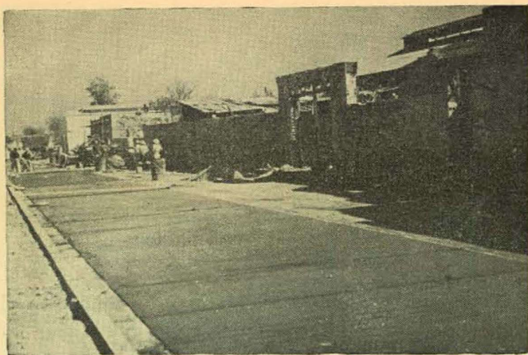
Trabajos de pavimentación en la Calle 16, C. Victoria.
