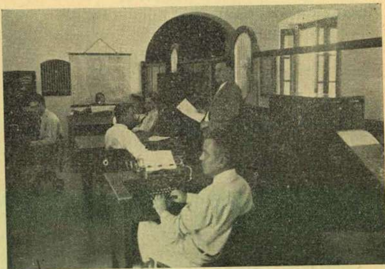
Tesorería General.—Sección de Recaudación.—Totalmente equipada con muebles de acero.
