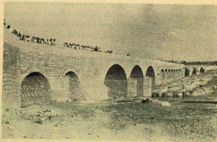
Puente "Bernardo Gutiérrez de Lara" sobre el Río Salado, a la altura de C. Guerrero.—Carreteras de la Frontera, tramo de C. Mier a C. Guerrero.
