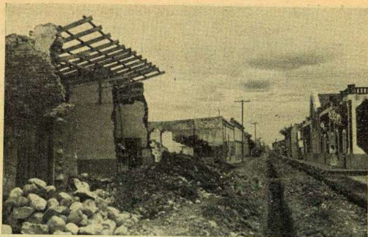
Alineamiento de la Calle Morelos, C. Victoria, y arreglo de las instalaciones de agua y drenaje, como trabajo previo para las obras de pavimentación.
