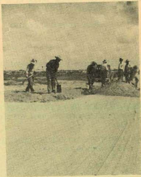
Carretera Matamoras-Mazatlán. Tramo Reynosa-Río Bravo. Tendido de material de revestimiento.
