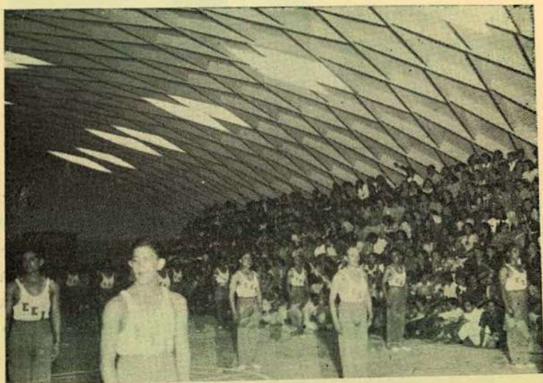
Escuela Secundaria "José de Escandón", en Ciudad Reynosa. Dos aspectos del gimnasio, cubierto con un elegante y atrevido techo tipo "Lamella" (el primero de su clase construído en México).
