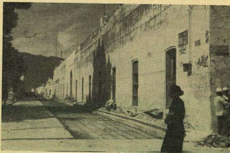
Trabajos de pavimentación en la Calle Morelos, de C. Victoria.
