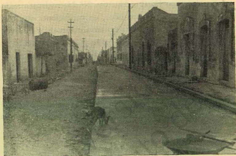
Trabajos de pavimentación en la Calle de Matamoros, C. Victoria.
