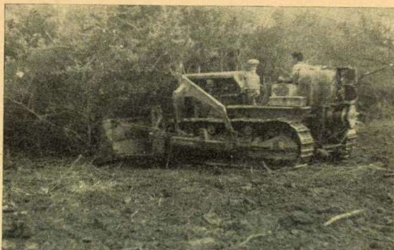
Carretera Matamoros-C. Victoria, trabajos de desmonte con Bulldosser.
