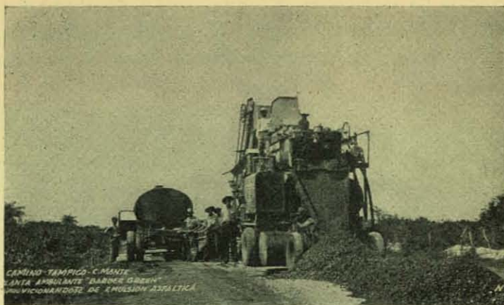
Planta "Barber-Greene", preparando emulsión asfáltica para la carretera C. Mante-Tampico.
