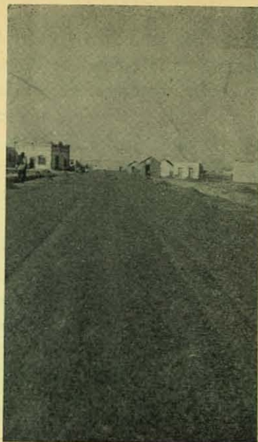
Cubierta asfáltica sobre el tramo Reynosa-Jabalí.
