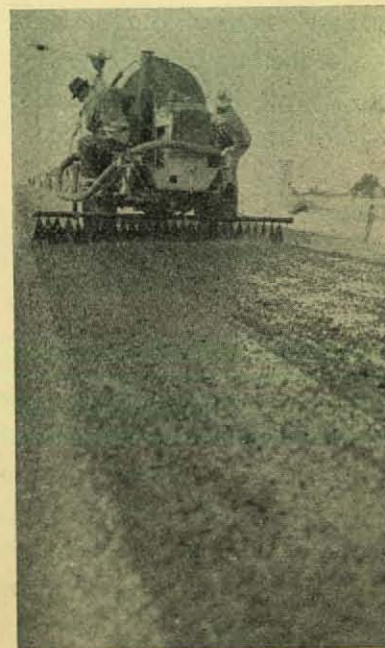
Tercer riego en el Tramo Reynosa-Jabalí de la carretera Matamoros-Mazatlán.
