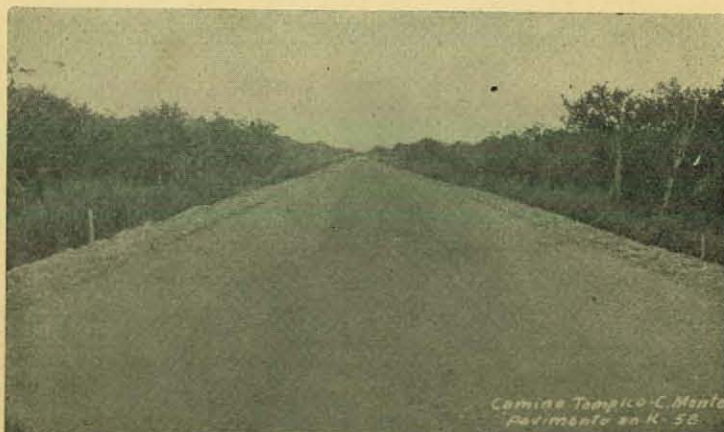
Otro aspecto de la pavimentación en el Kmt. 58.
