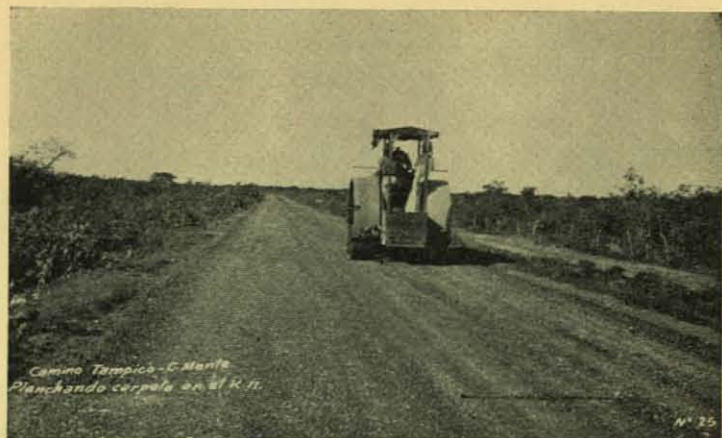
Planchado de la Carpeta sobre la carretera C. Mante-Tampico. Kmt. 11.
