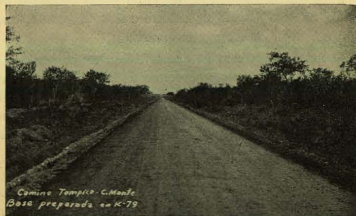
Base preparada para pavimentación en el Kmt. 79 de la carretera C. Mante-Tampico.
