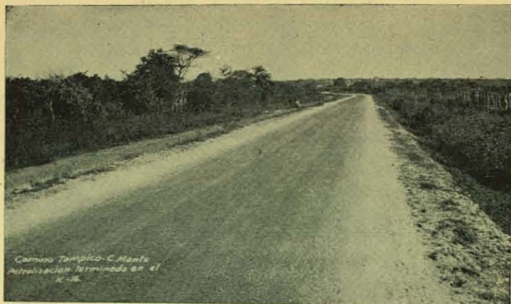
Aspecto del camino, ya pavimentado, Kmt. 16 de la carretera C. Mante-Tampico.
