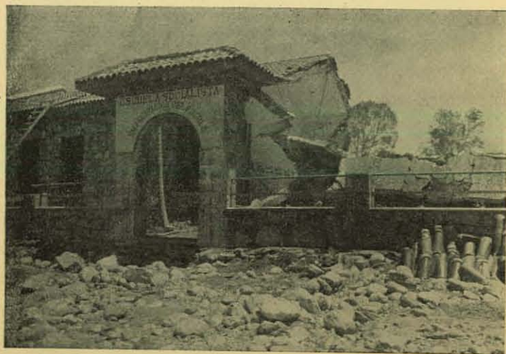
El viento y el agua pusieron por tierra la Escuela "Emancipación del Pueblo".
