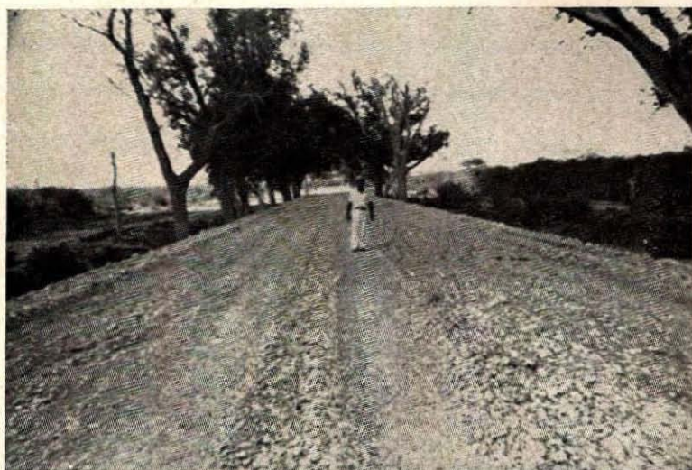
Camino Victoria-Matamoros. Revestimiento terminado en el kilómetro 55.
