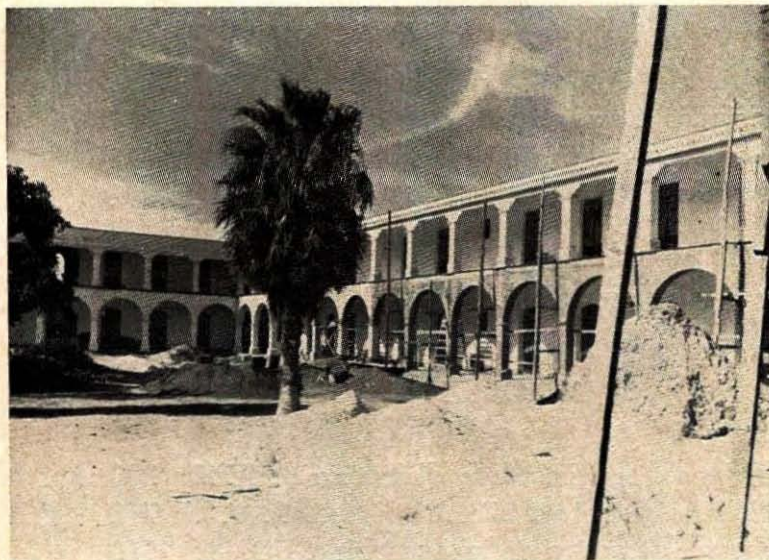
Vista interior de la Escuela Anexa a la Normal.
