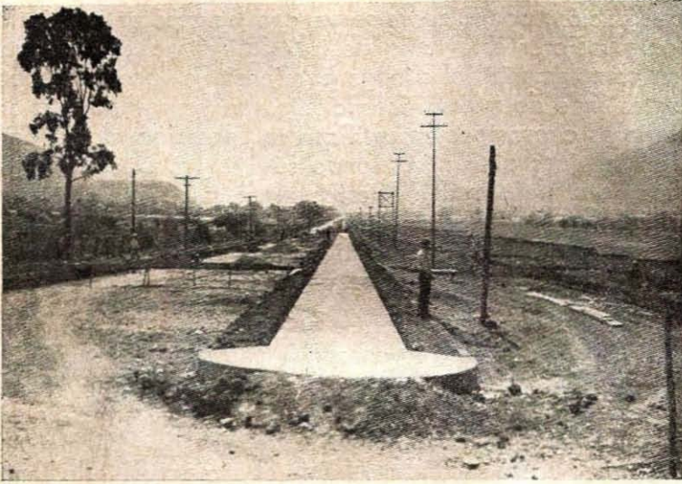
Calzada Victoria a Tamatlán. Otra vista del camellón central.
