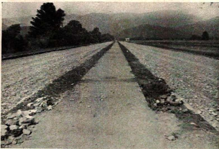
Camino Victoria-Matamoros. Río Purificación. Banco de grava para revestimiento.
