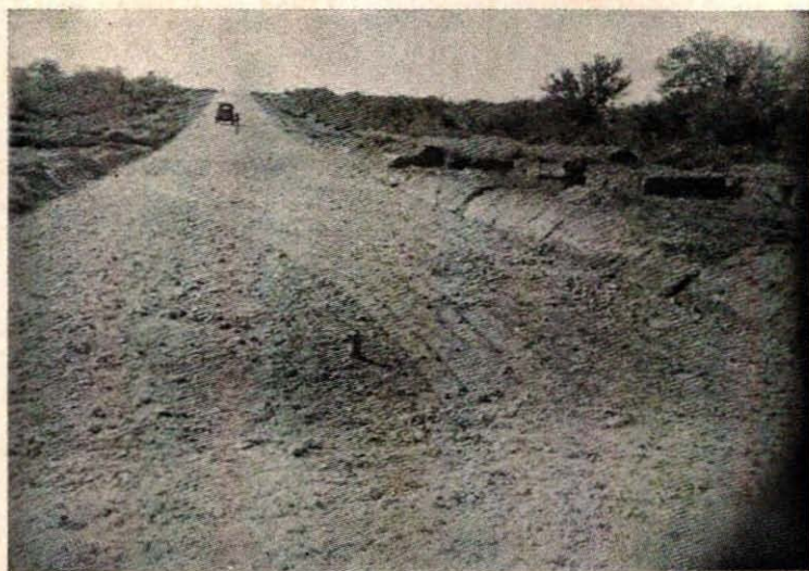
Camino Victoria a Tula. Revestimiento del kilómetro 50.
