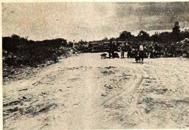
Camino Victoria a Tula. Revestimiento de la calzada a Tamatlán.
