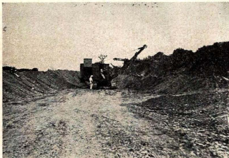
Camino Victoria-Matamoros. Construcción del estribo número 1 del Puente del Piloncillo.
