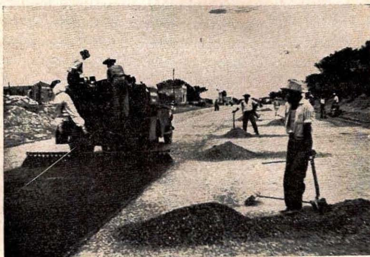
Trabajos de petrolización en la Avenida Carrera Torres de Ciudad Victoria.
