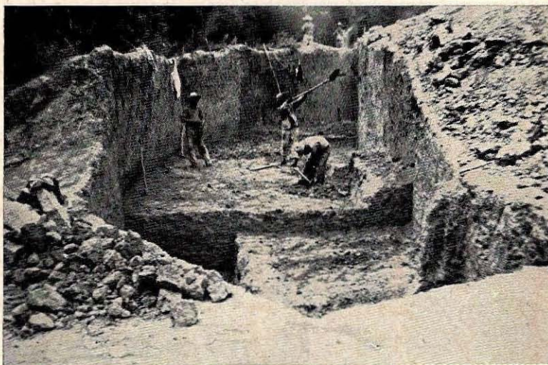
Camino Victoria-Matamoros. Excavación para estructura del Puen- te del Piloncillo.
