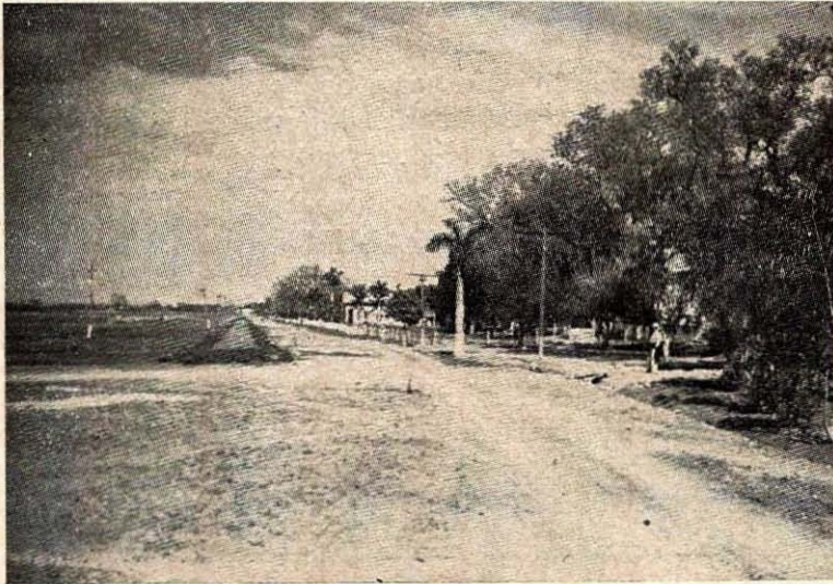
Calzada Victoria a Tamatlán. Construcción de terracerías.
